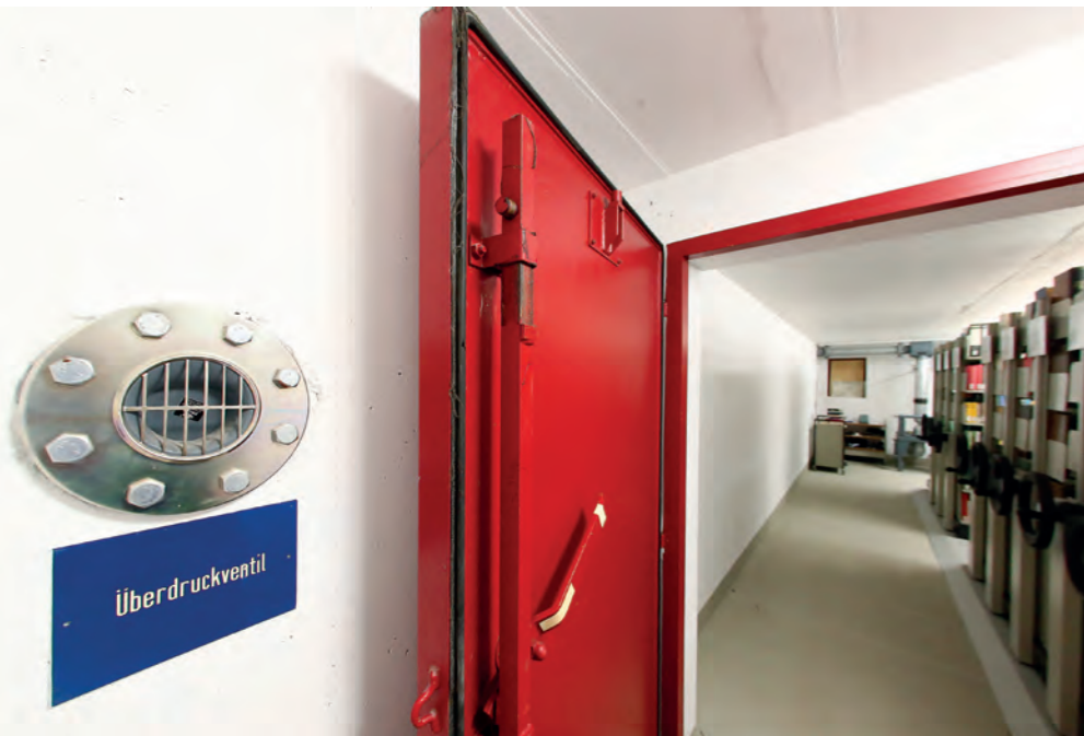
Gasdichte Zugangstüre zum Bunker. Foto: Peter Kolb
