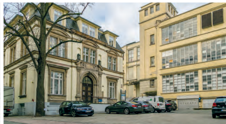
Das ehemalige Verwaltungsgebäude (I.) der Spinnerei soll Uni-Verwaltung, Dekanat, Besprechungszentrum sowie Heimat für erste Professuren des Campus Kulmbach werden. Foto: Tina Endres/UBT
