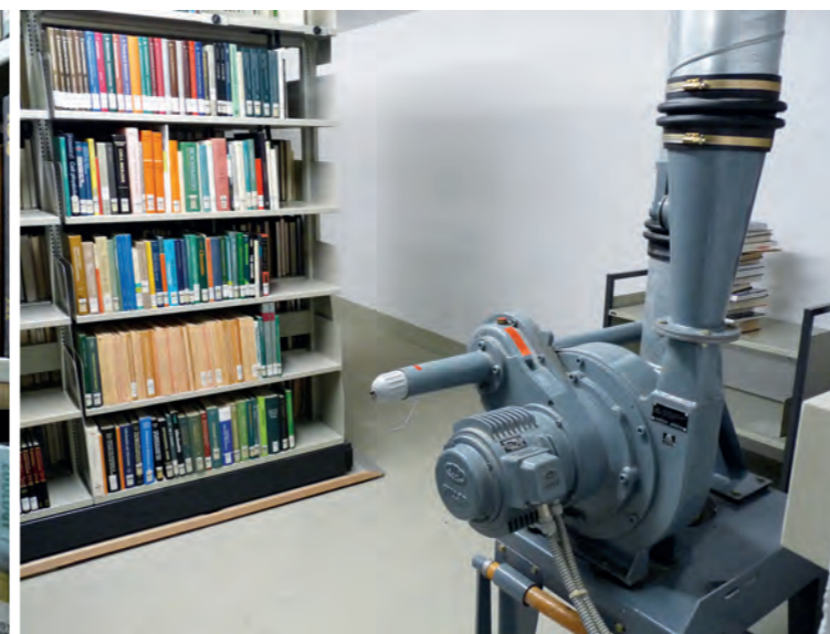
Alte und neue Funktion auf einen Blick: Die verbliebene Lüftungsanlage aus der Zeit des Luftschutzbunkers und die heutige Bibliothekseinrichtung.
