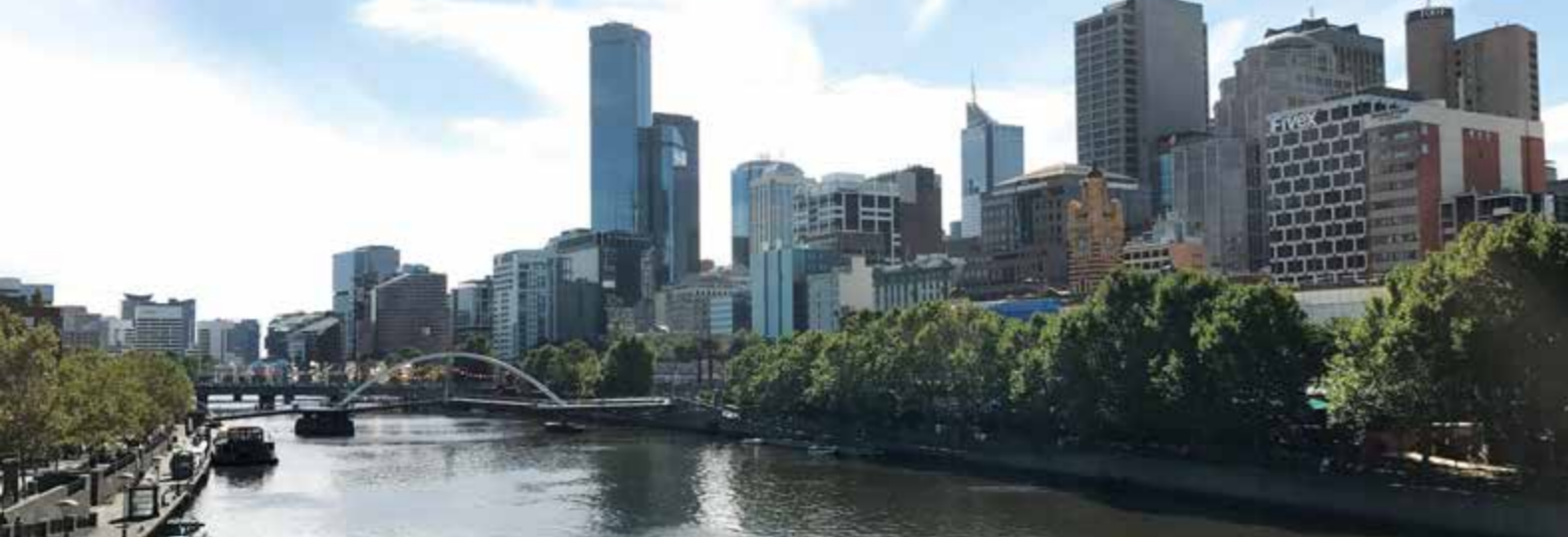
Brücken bauen: Blick über den Yarra River von der Princes Bridge westwärts zur Evan Walker Bridge, Sandridge Bridge und Queens Bridge in Melbourne. Foto: Armin Heinemann
